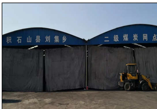
全封闭煤存储大棚
