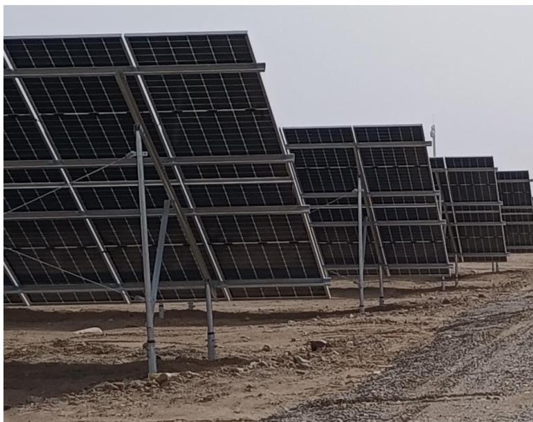
图 4-2 螺旋桩固定支架基础示意图
